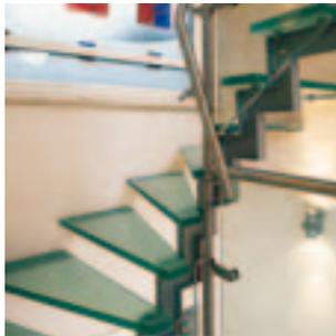
Entsprechend den bauaufsichtlichen Anforderungen besteht SWISSSTEP aus drei thermisch vorgespannten Einzelscheiben, die mittels zwei zähelastischen Kunststoffschichten dauerhaft miteinander verbunden sind. Der große Vorteil von SWISSSTEP: Die obere Scheibe ist nicht durchbohrt. So wird größtmögliche Transparenz der Glastreppe gewährleistet und der harmonische Gesamteindruck der Glasoberfläche nicht gestört.
